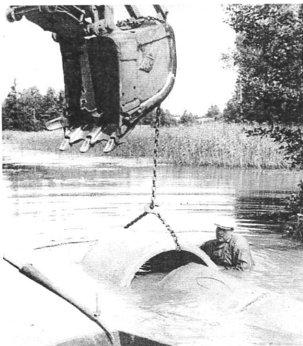
Algot Johansson från Yxtatorpet mättar in ett av betongrören till trumman genom Barröbanken
